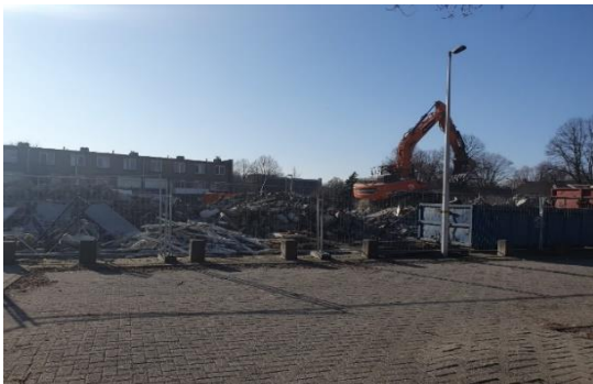
Foto 1.1: Sloop en aanstaande nieuwbouw in de Maastrichtse wijk Malpertuis (2023)
