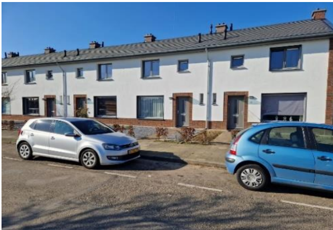
Foto 1.2: Verduurzaming en renovatie in de Maastrichtse wijk Nazareth (2023)
