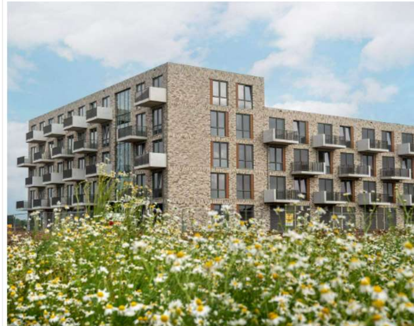
Prefab gebouwd wooncomplex in Culemborg. © Heijmans
